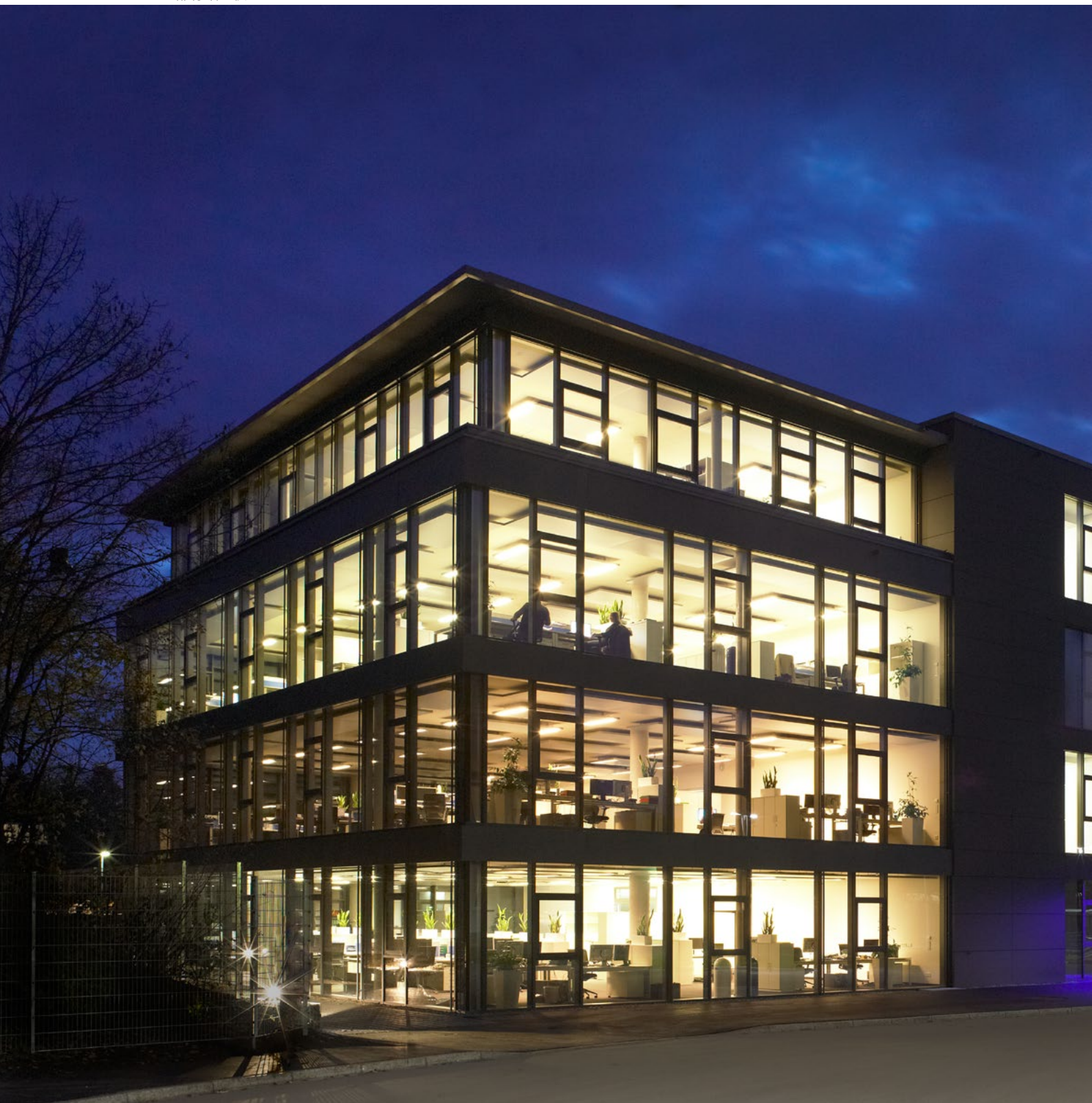
BHS-Sonthofen 总部行政大楼
