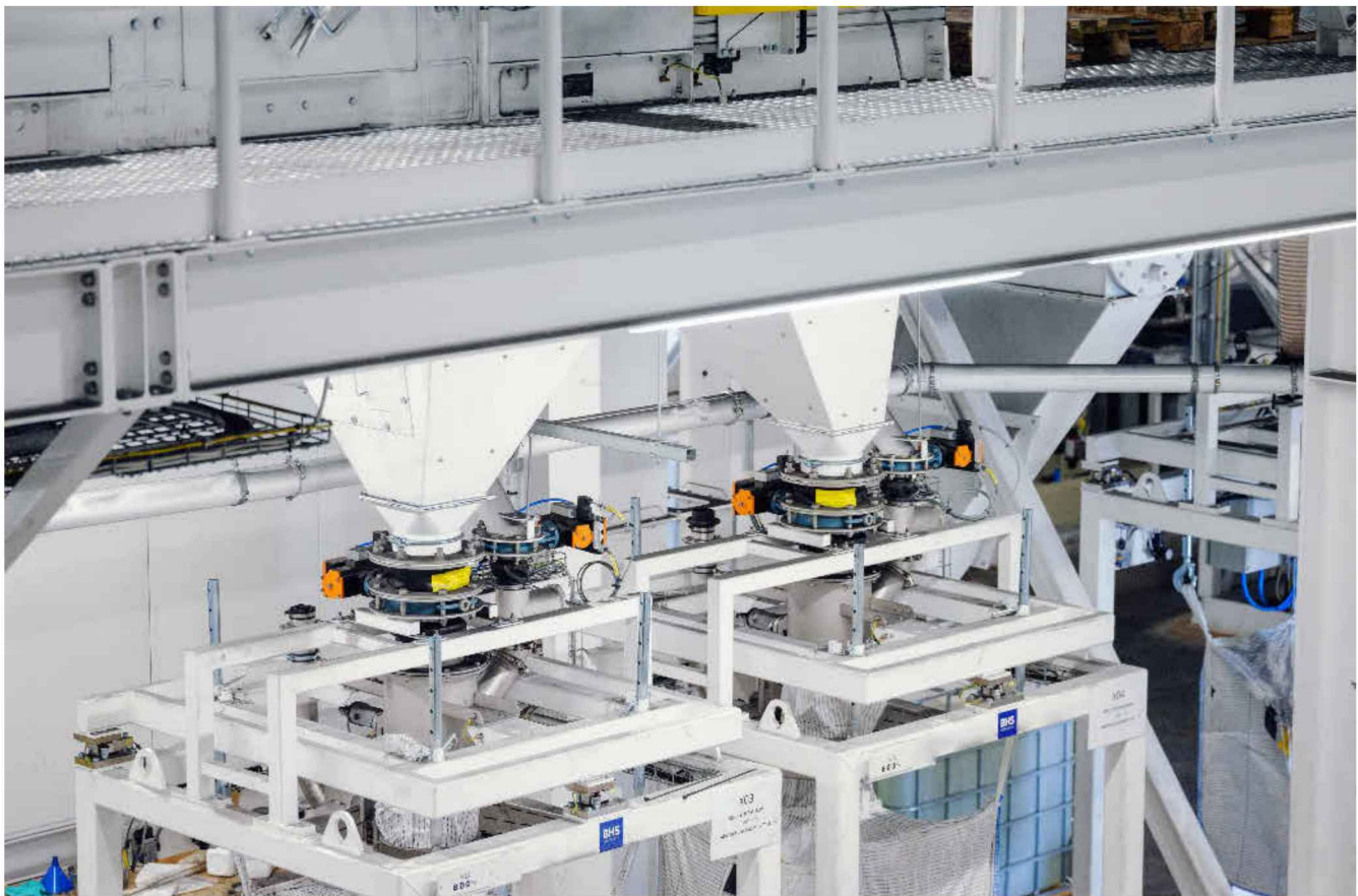
Bei Hydrovolt in Norwegen werden Lithium-Ionen-Batterien aus der Industrie und aus Fahrzeugen in einer Anlage aus Oberbayern recycelt. Hier werden Big Bags mit schwarzer Masse und Metallen gefüllt. Foto: Hydrovolt
